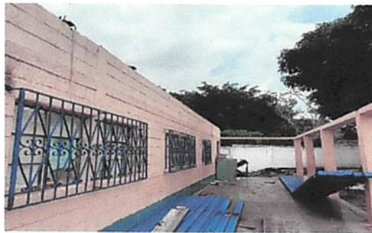
Foto 3: Modulo 3 listo para instalar estructura de soporte de metal
