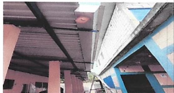
Foto 6: Instalación de canal de metal
