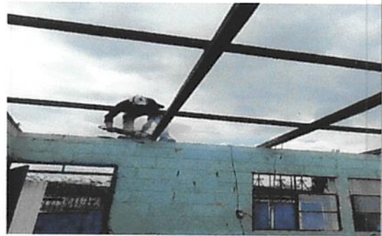
Foto 2: Desmontaje de estructura de soporte de madera
