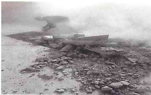
Foto 11: Retirando torta de concreto liso en mas estado
