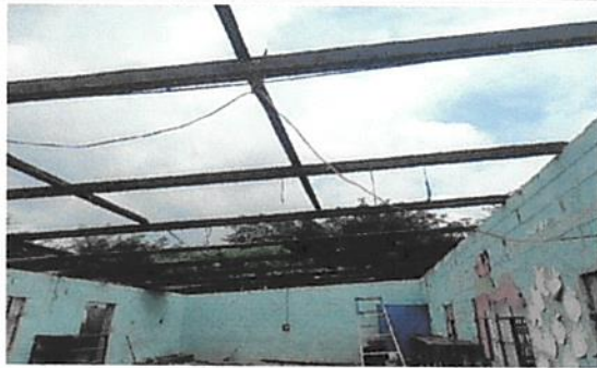
Foto 1: Desmontaje de laminas y capote
