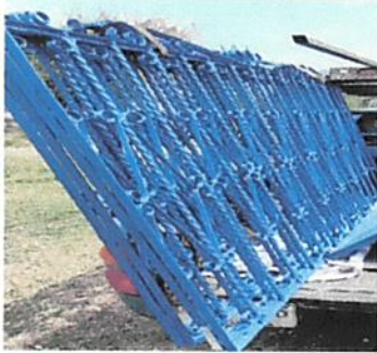
Foto 9: Balcones de metal pintados y listos para reinstalar
