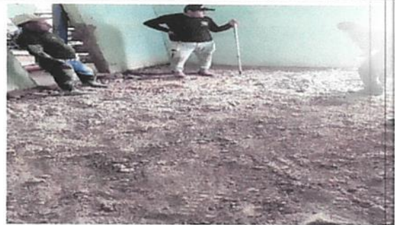
Foto 12: Area preparada para la colocación de torta de concreto
