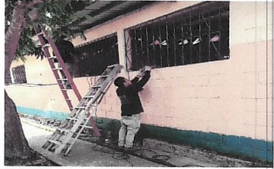
Foto 8: Lijado y cepillado de balcones de metal
